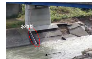
台風19号襲来時の水位計被災状況
