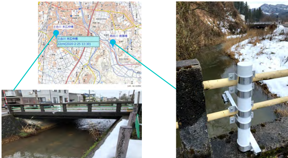
頻繁に越水する住宅地内の小河川
