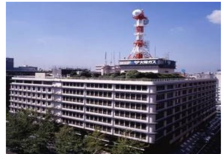
本社ガスビル(大阪府中央区)
